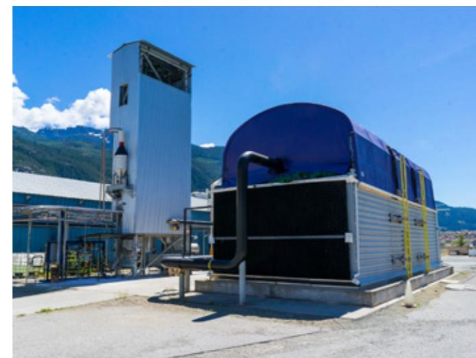
碳工程公司的直接空气捕集工厂试点。图中为空气接触器和煅烧炉（左）
