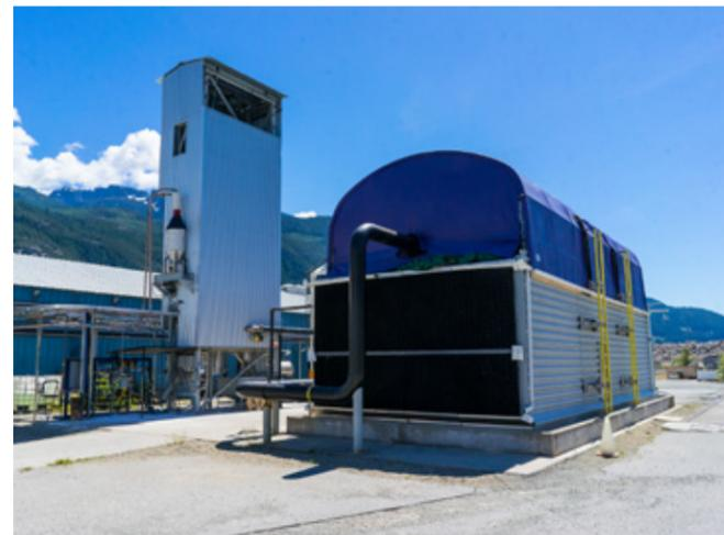
碳工程公司的直接空气捕集工厂试点。图中为空气接触器和燃烧炉（左） 图片来源：Carbon Engineering Ltd.
